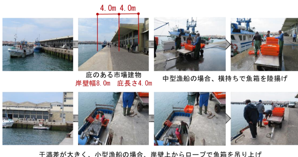
図 3.3.4 陸揚げ・場内搬入
