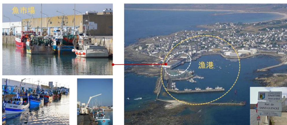
図 3.6.1 サンゲノレ - パンマール港
