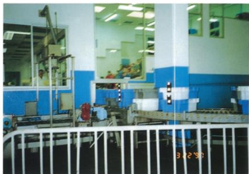
選別室からセリ室へ魚箱を移送するコンベヤ
