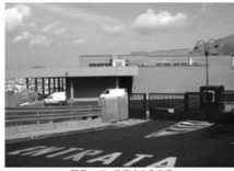
写真-17 改修中の魚市場
