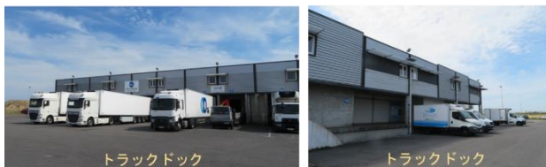
トラックドック
