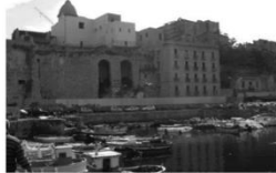
写真-18 改修中の魚市場
