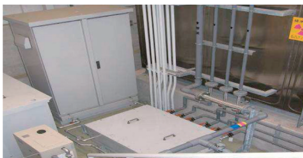
RI施設排水設備
