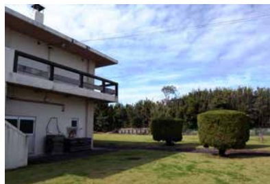
富浦ステーション/宿泊施設と広場
