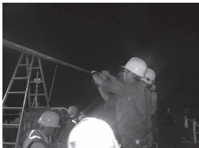
船上での作業風景
